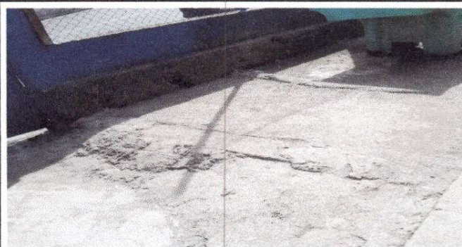
Foto 8: Reparación de planchas de concreto, de patio
