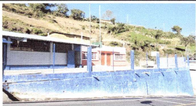
Foto 7: Reparación de tubo HG y malla galvanizada
