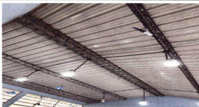
Foto 9: Sustitución de focos ahorradores
