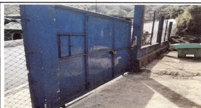
Foto 6: Mantenimiento a portones de metal
