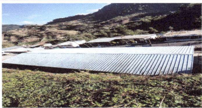
Foto 1: Sustrucción de lamina, por lamina troquelada aluzinc calibre 26 + Sustrucción de elementos de fijacion
