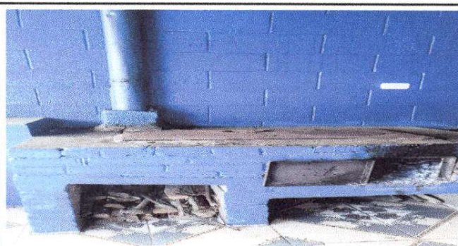
Foto 11: Sustitución de estufa rural (completa) incluye chimenea y plancha de metal
