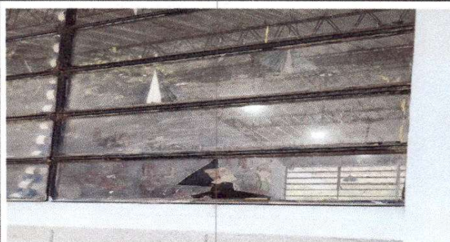
Foto 4: Sustrucción de vidrios
